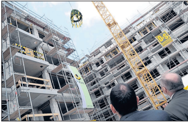
Es geht aufwärts: Erster Bürgermeister Christian Specht (links) und Bauunternehmer Heinz Scheidel verfolgen das Hochziehen des Richtkranzes.
