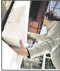
Das Thema Fassadendämmung steht bei der Projektschau im Juli an.
