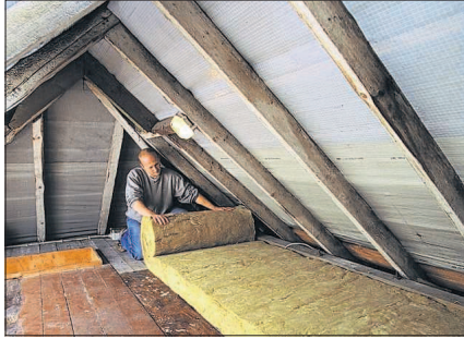
Projektwochen im August: Dachdämmung.
